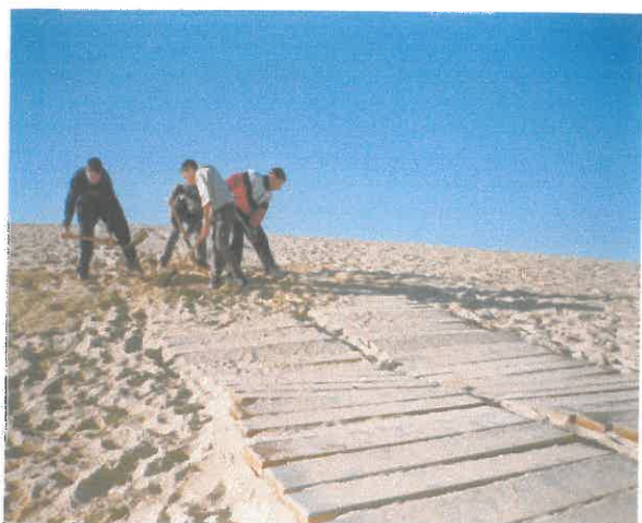
Distribuidos en grupos ó longo da pasarela.
