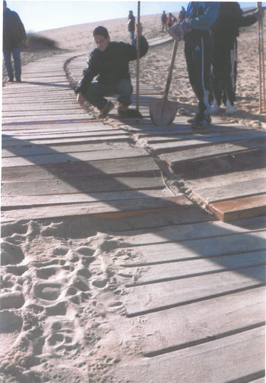
Inspeccionando o estado da pasarela.
