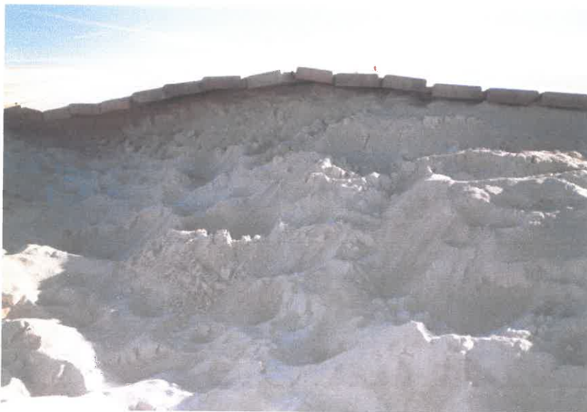
Resultaba perigoso camiñar pola pasarela.
